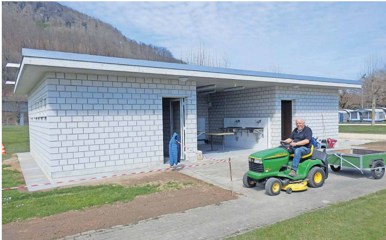
Präsident Beat Meyer im Endspurt beim Bau des neuen Sanitärgebäudes
