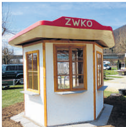
Altes Kassenhäuschen Ruppoldingen (frisch renoviert).
