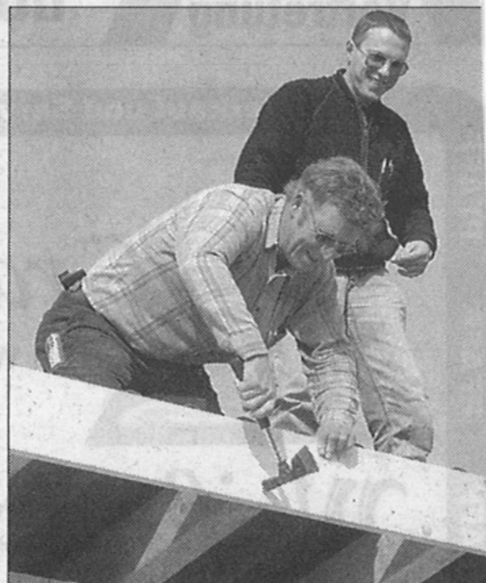
Letzte Arbeiten am Dach.
